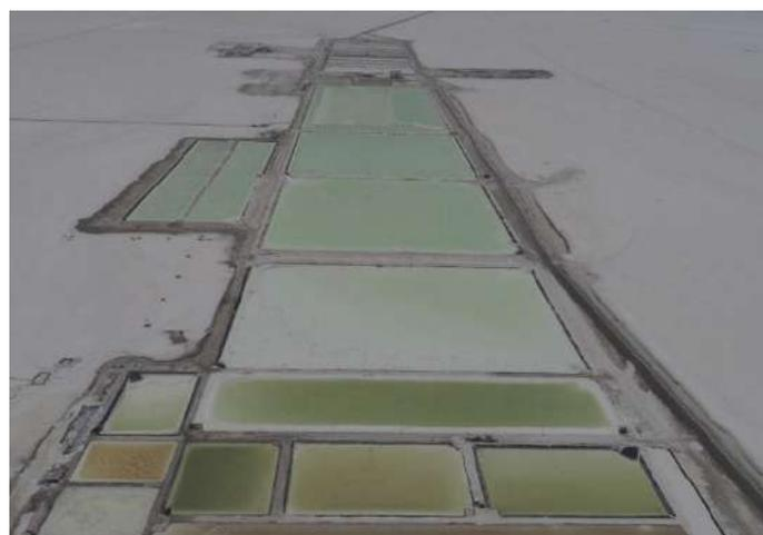
Figura 1: Piscinas de Evaporación en serie escala semi-industrial - Circuito Acoplamiento
