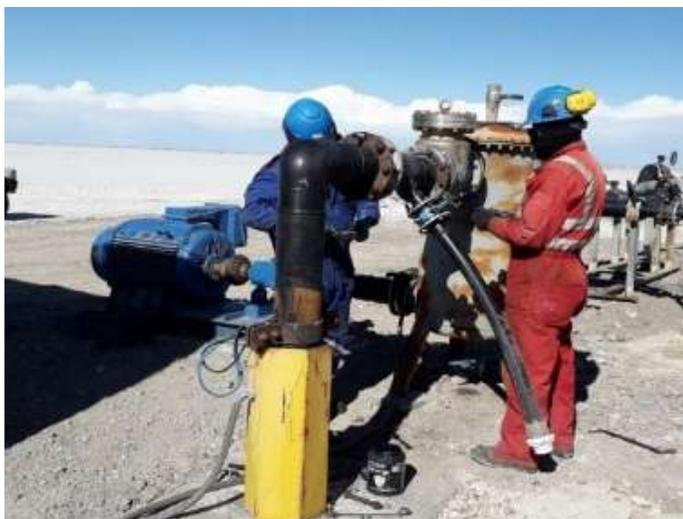
Figura 22. Montaje de tuberías en pozos de extracción de salmuera.
