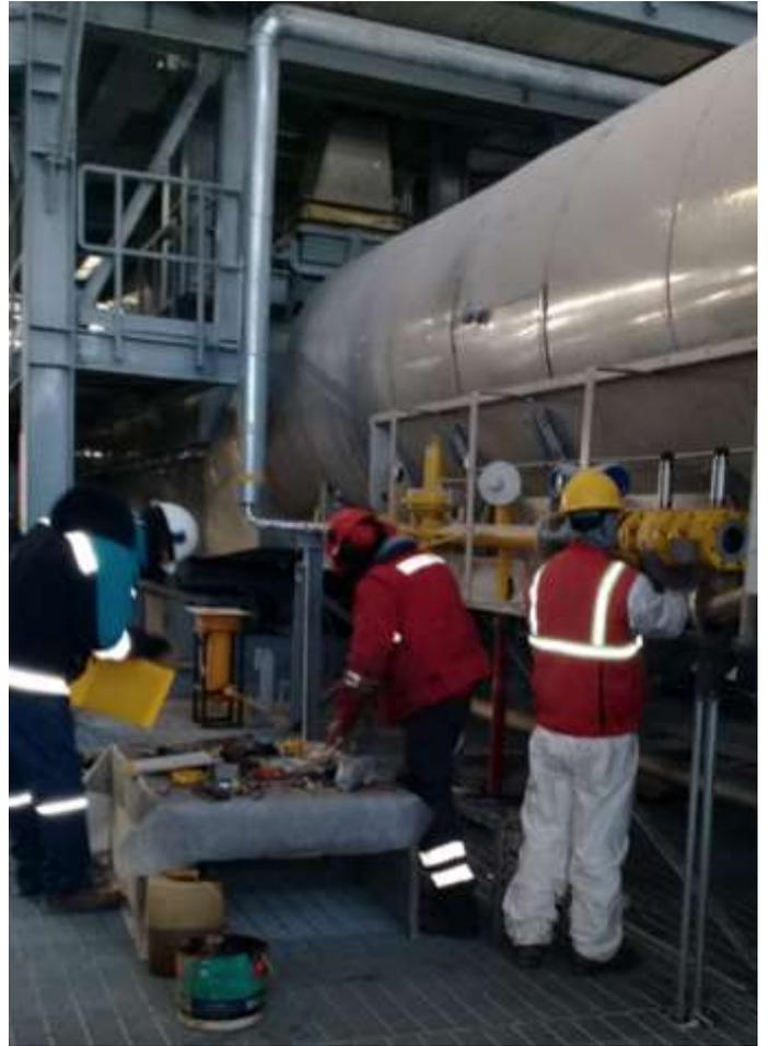
Figura 32. Mantenimiento de puente de regulación de GLP
