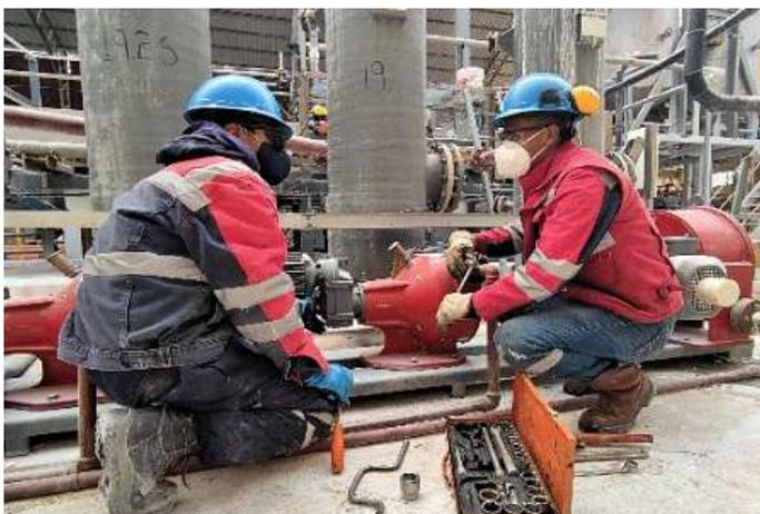
Figura 23. Mantenimiento de bombas peristálticas en la Planta Piloto de Carbonato de Litio.
