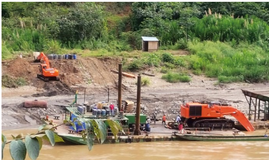
Planchón colombiano con maquinaria pesada, instalado al ingreso del municipio de Teoponte sobre el río Kaka.
