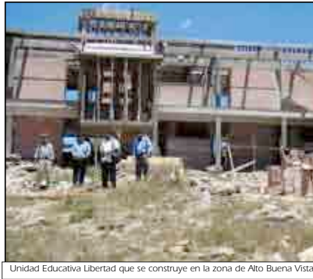
Unidad Educativa Libertad que se construye en la zona de Alto Buena Vista
