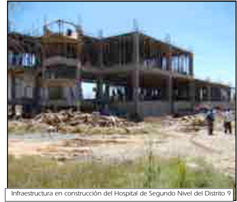
Infraestructura en construcción del Hospital de Segundo Nivel del Distrito 9
