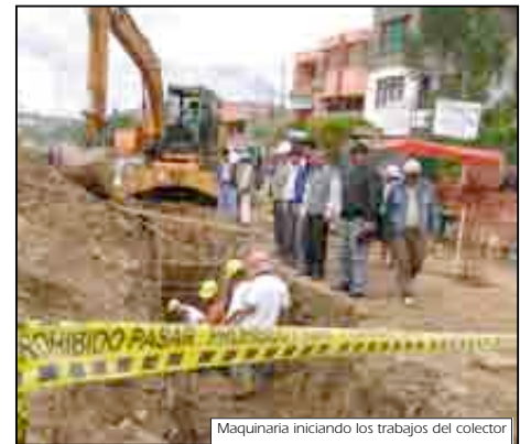
Maquinaria iniciando los trabajos del colector
